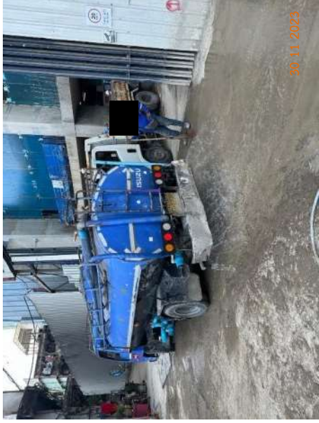
รูปที่ 2-13 การฉีดพรมน้ำและทำความสะอาดบริเวณถนน รอบพื้นที่ก่อสร้างเพื่อลดฝุ่นละออง
