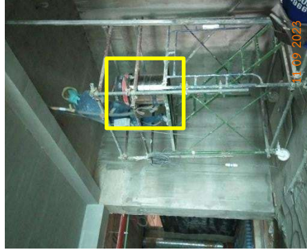
รูปที่ 2-65 การใช้เครื่องตูดฝุ่นที่แหล่งกำเนิด
