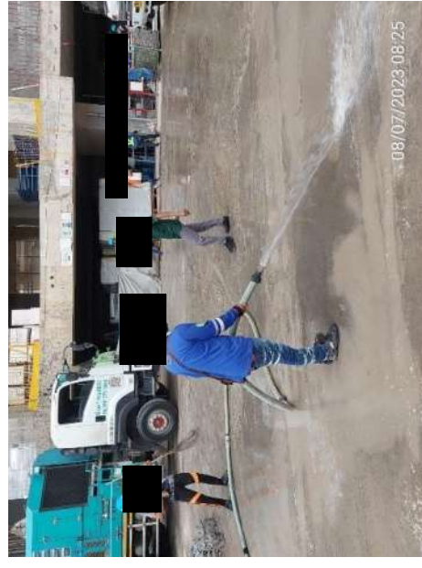
รูปที่ 2-8 การฉีดพรมน้ำและทำความสะอาด ภายในพื้นที่ก่อสร้างเพื่อลดฝุ่นละออง
